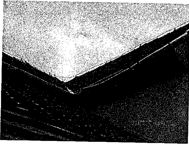
Belső udvari hajlat, függőeresz csatorna sérült
