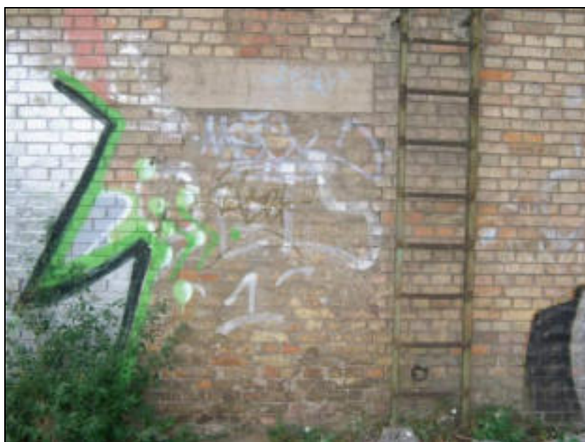
Befalazott ajtó a keleti homlokzaton
