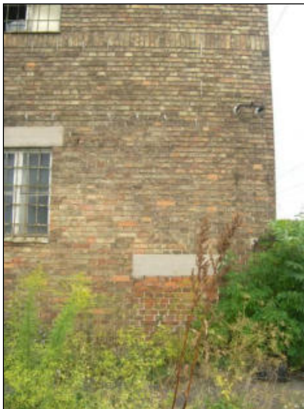
Befalazott nyílás a nyugati homlokzaton.
