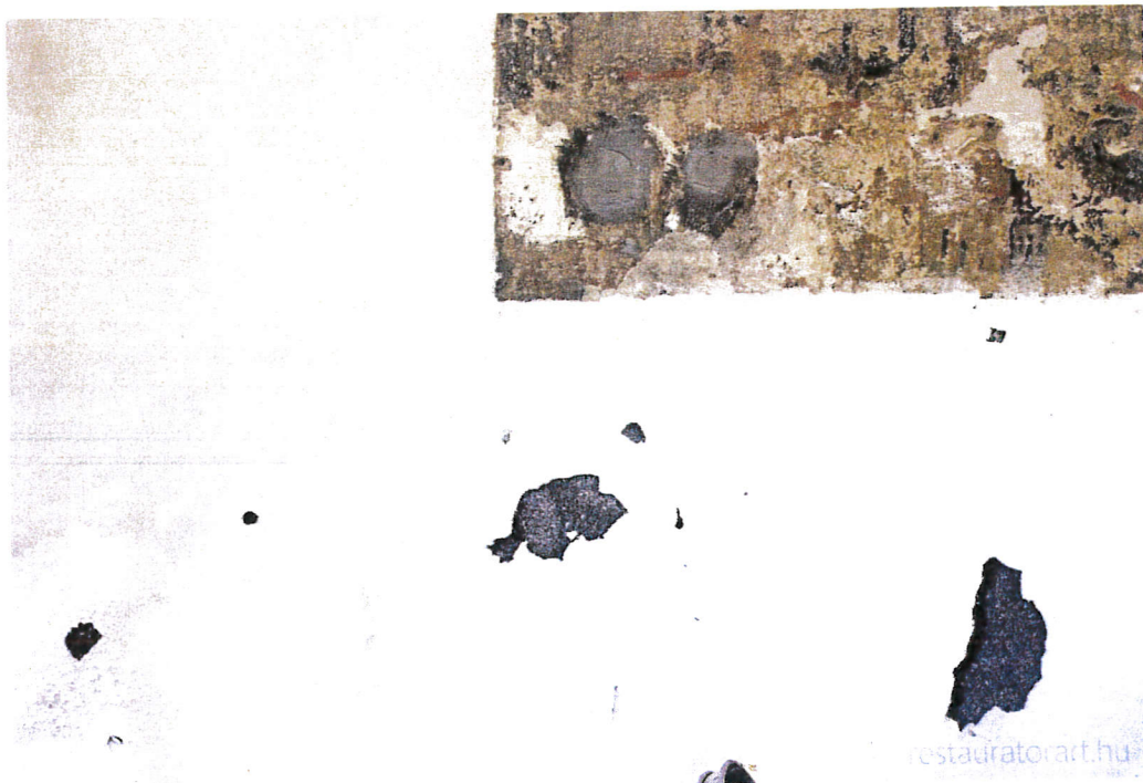
A talajnedvesség által okozott kár
