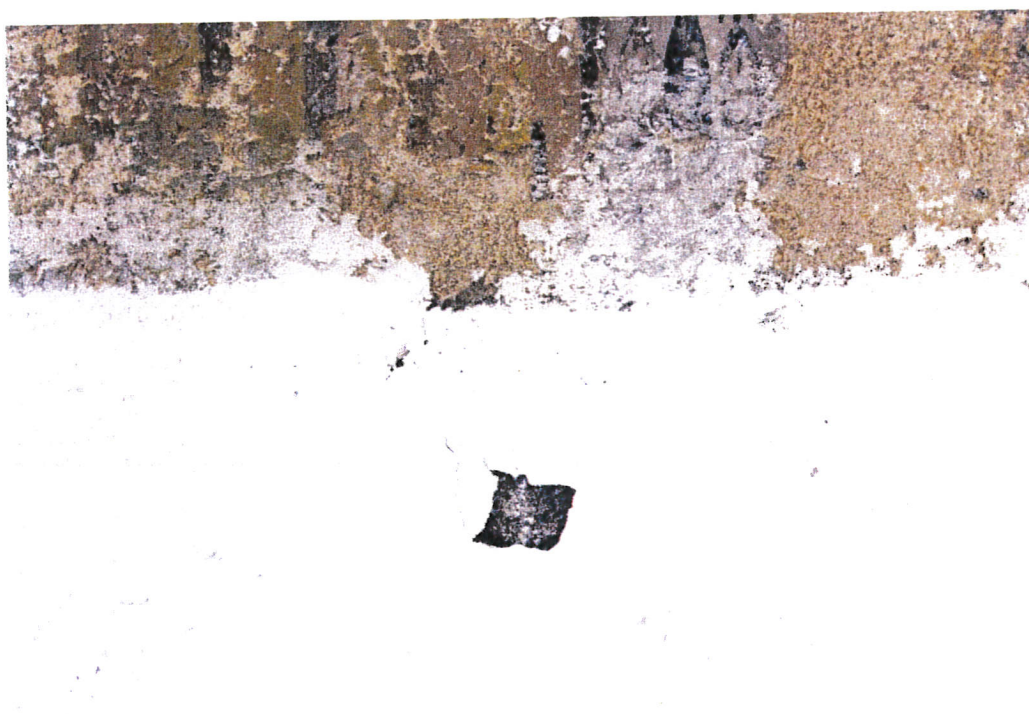
A magas páratartalom és a nedves falak a fal meszelésének és a festmény festékrétegének leveles leválását okozta
