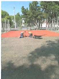
Clementis utcai labdapálya gumiburkolatának felújítása
