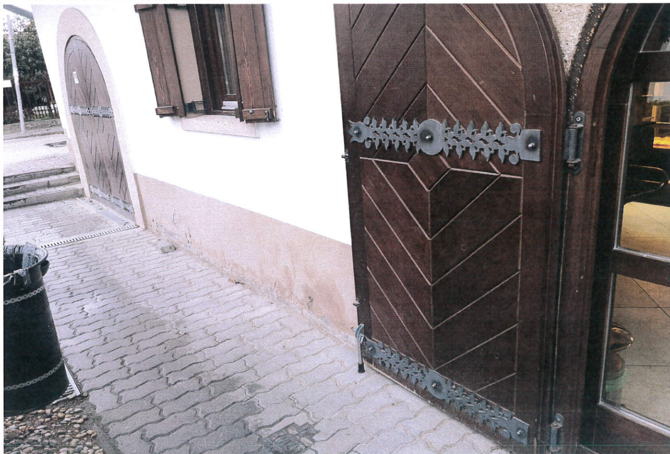
2. 1. ábra : Károsodott lábazat :
